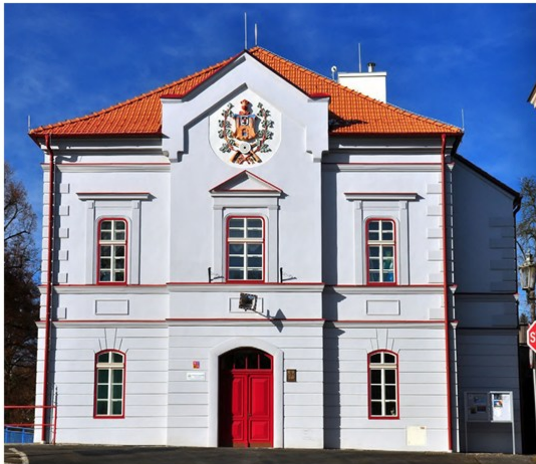
Obrázek 11: Vnější zateplovací systém s reprofilací pomocí izolantu; foto: archiv projekty Sedláková +Baumit
