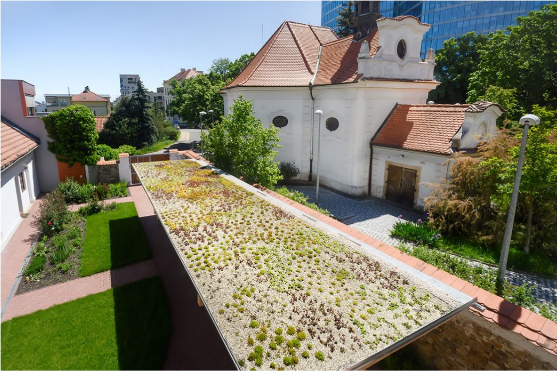
Obrázek 52: Extenzivní vegetační střecha přístřešku; foto: Karel Šuster
