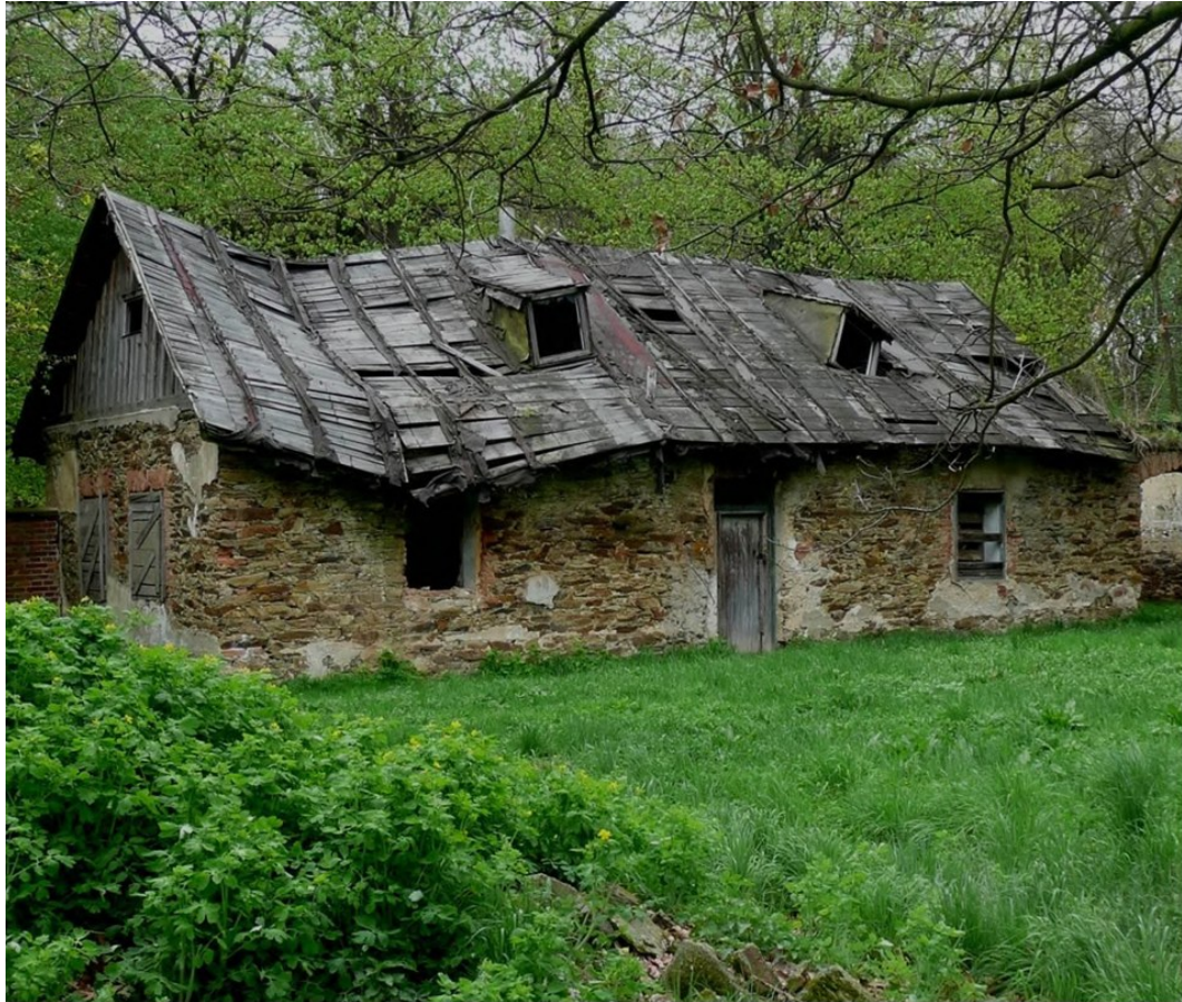
Obrázek 57: Původní stav budovy; foto: Josef Smola, Centrum pasivního domu z.s.
