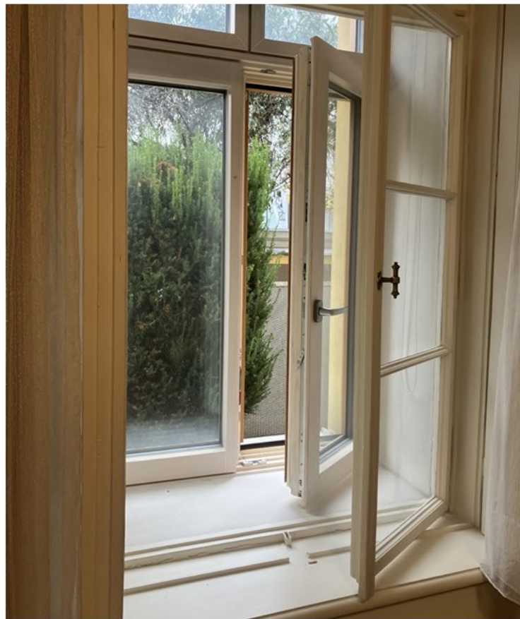
Obrázek 56: Řešení špaletových oken – vnitřní profil s jednoduchým zasklením (replika), vnější křídlo s izolačním trojsklem v nízkém okenním profilu; foto: Michal Čejka, Centrum pasivního domu z.s.
