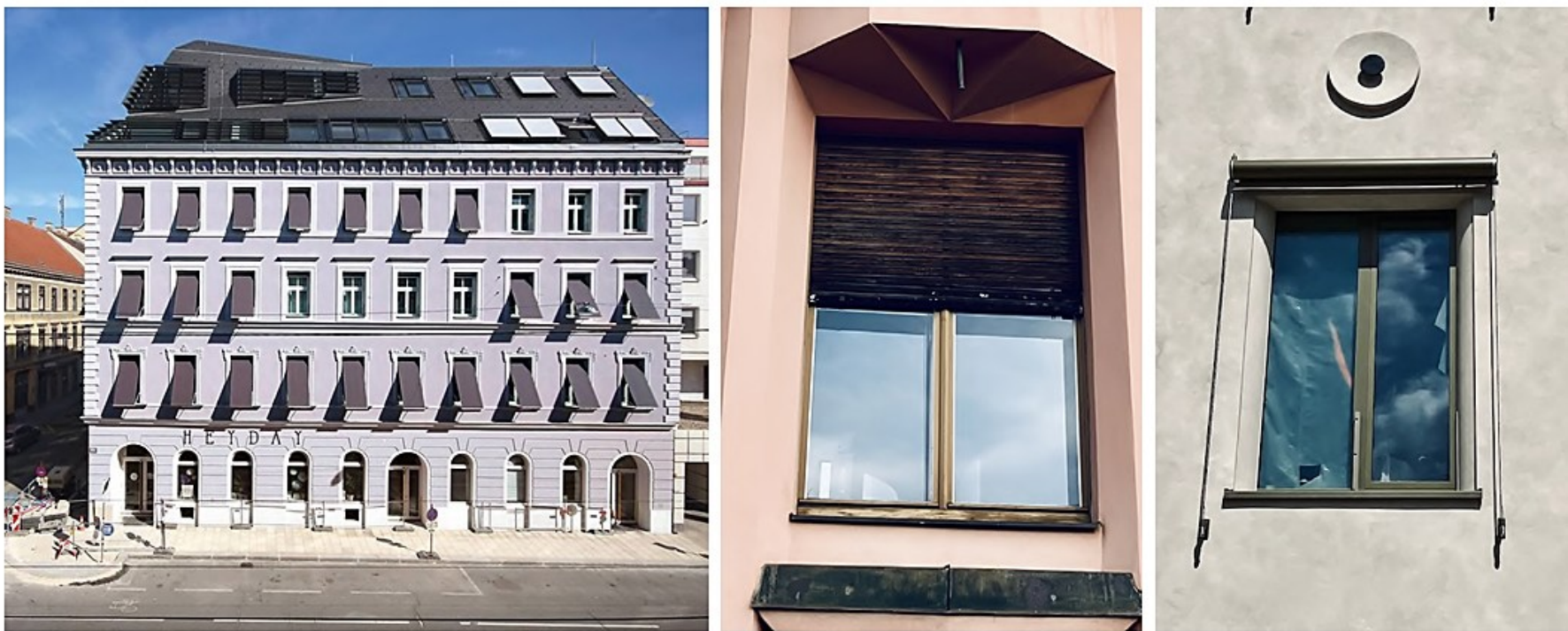
Obrázek 35: Příklady řešení vnějších stínících prvků na historických budovách; zdroj: Hiberatlas + foto: Michal Čejka
