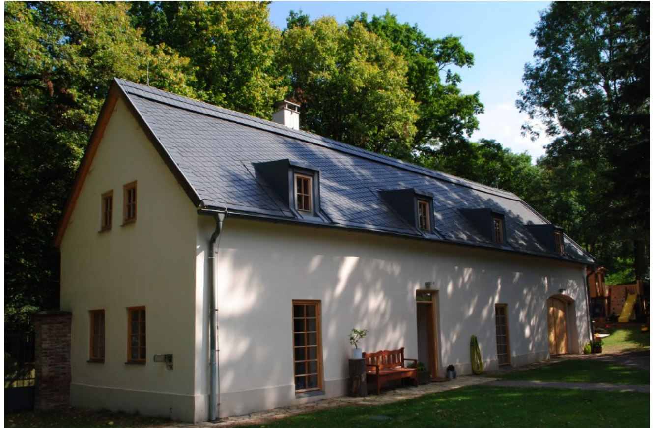
Obrázek 58: Stav po realizaci; foto: Josef Smola, Centrum pasivního domu z.s.
