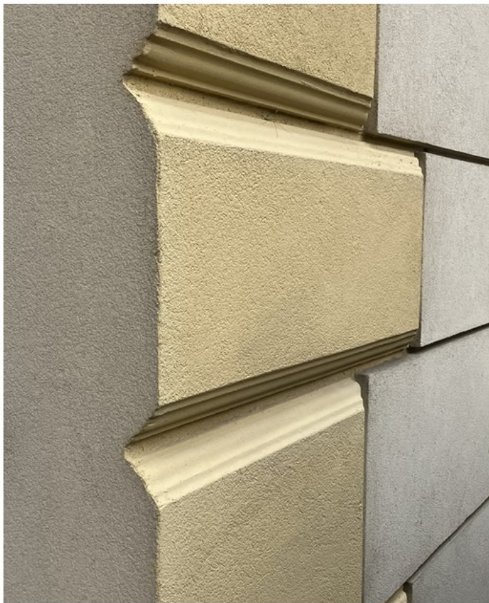
Obrázek 55: Reprofilace zdobných prvků; foto: Michal Čejka, Centrum pasivního domu z.s.
