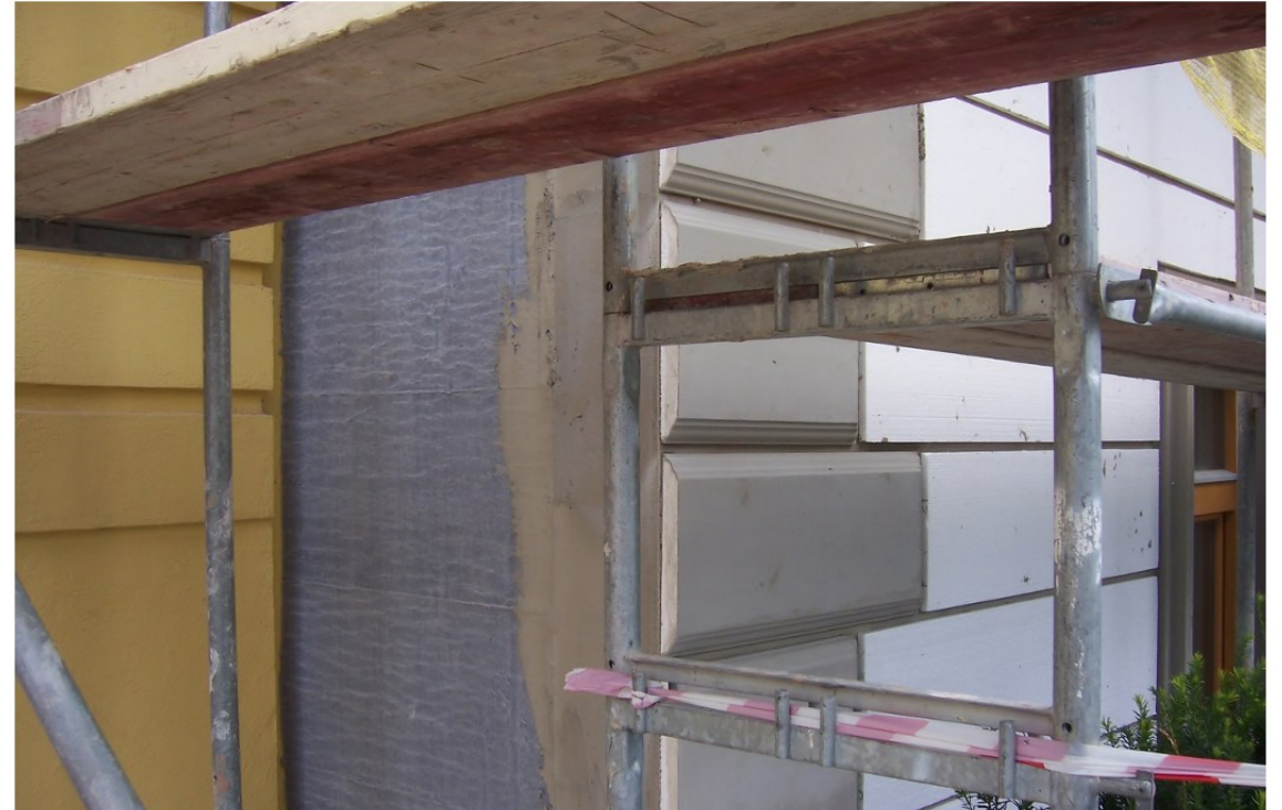
Obrázek 53: Reprofilace zdobných prvků a aerogel na štitové stěně před finální povrchovou úpravou; foto: Propasiv s.r.o.
