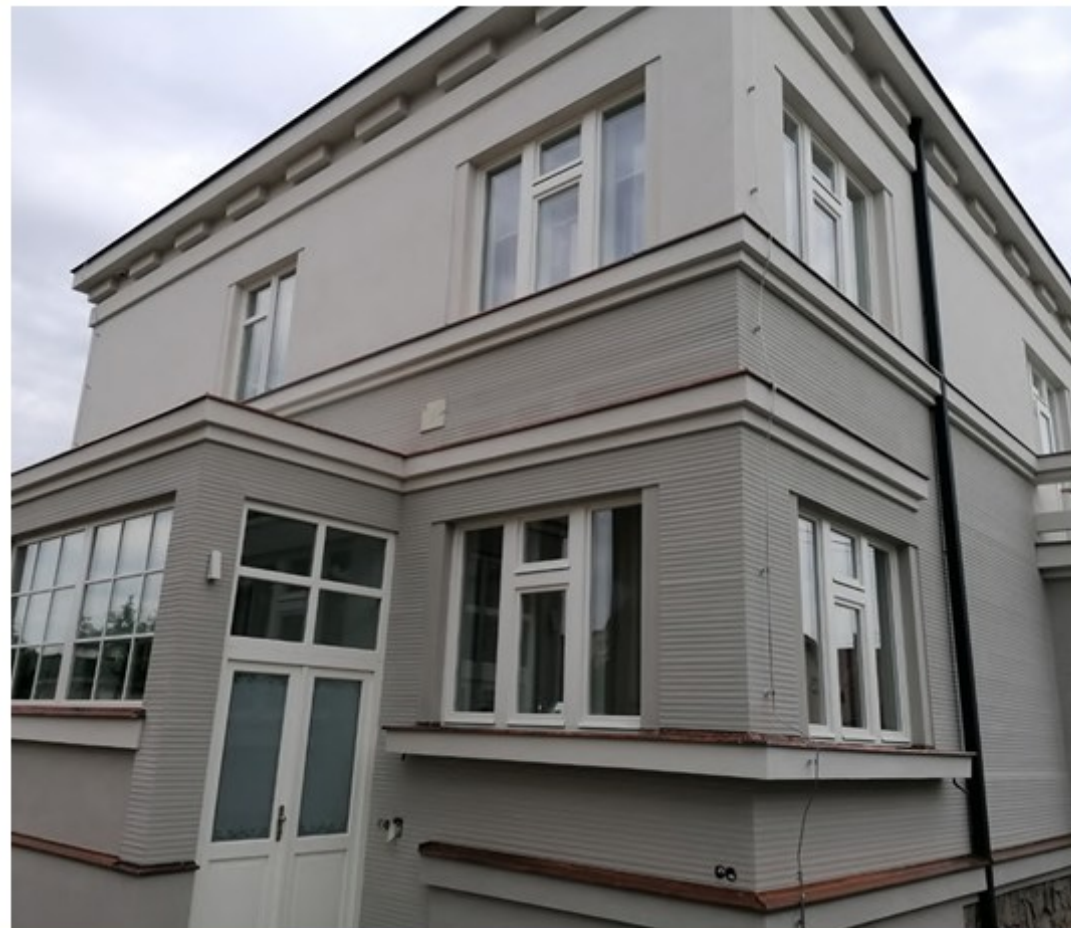
Obrázek 11: Vnější zateplovací systém s reprofilací pomocí izolantu; foto: archiv projekty Sedláková +Baumit
